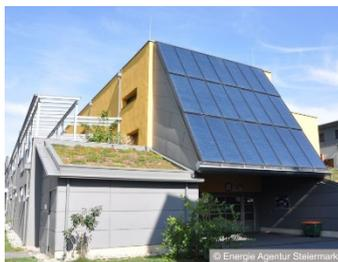
Größere Solaranlagen liefern Warmwasser und unterstützen gleichzeitig die Raumheizung. Das spart Kosten, Brennstoff und CO<sub>2</sub>-Emissionen.
