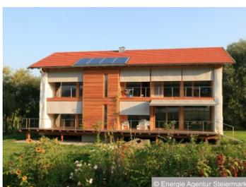
Eine einfache Solaranlage liefert warmes Wasser für Küche und Bad. Über das ganze Jahr betrachtet, können **bis zu 70% des Warmwasserbedarfs von der Sonne** bereitgestellt werden. Für einen Vier-Personen-Haushalt genügen 6 bis 8 m<sup>2</sup> Flachkollektoren in Verbindung mit einem 300 bis 500 Liter Warmwasserspeicher.
